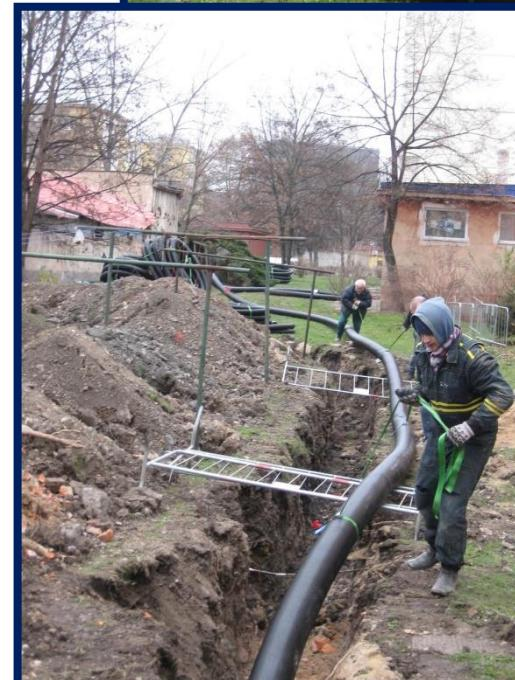
**Potrubi Flexalen má díky větší flexibilitě o více jak 70 % méně spojů oproti tradičnímu potrubí lepší proudění**
